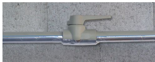
obalení plastového potrubí hliníkovou páskou
