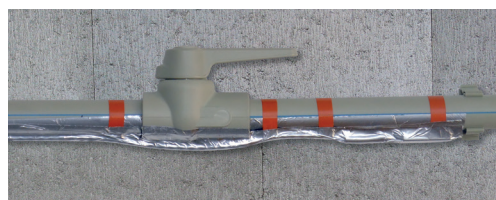
přelepení topného kabelu hliníkovou páskou
