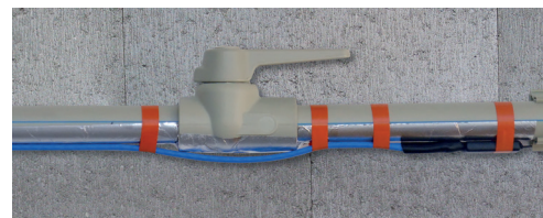
podélné natažení a připevnění topného kabelu montážní páskou
