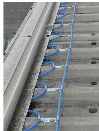
instalace topného kabelu na atypickém okraji střechy
