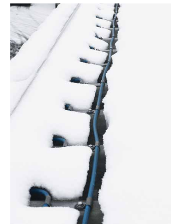
funkce topného kabelu instalovaného na atypickém okraji střechy
